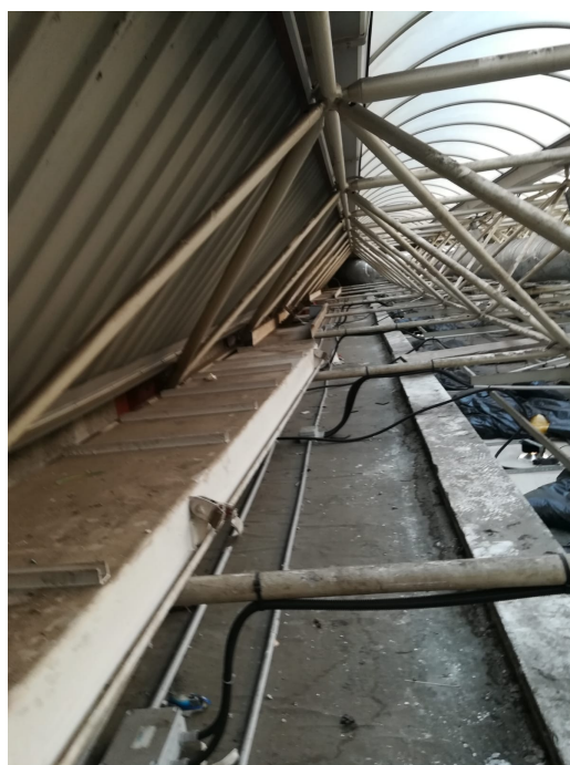
Figura 7 - vista della struttura reticolare di copertura
