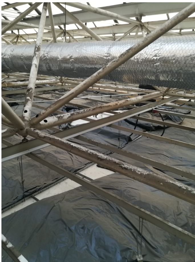
Figura 8 - vista estradosso controsoffitto in quadrotte
